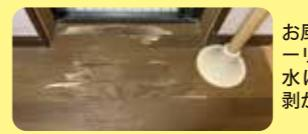
お風呂出入口の合板フローリングが傷んだ様子。水に濡れ続けて表面が剥がれています。
