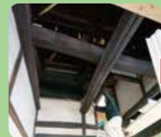
天井を撤去してハッキリ見えるようになった2本の立派な丸太梁。
