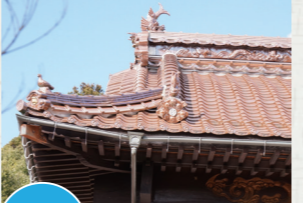
築21年 弊社施工物件の瓦屋根
