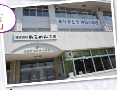
廃校になった小学校をリフォームした株式会社おこめん工房さん。弊社も工事に携わりました。
