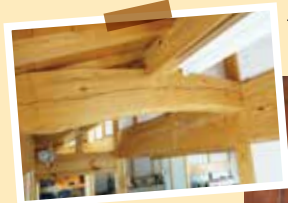
手仕事だから可能な、丸太の形を活かした木組み
